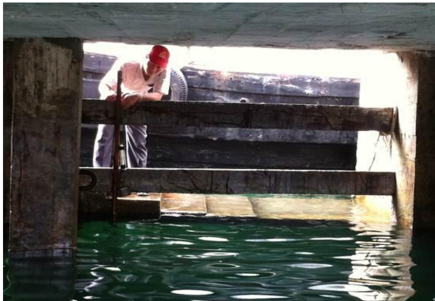
Hình 3.4. Lắp đặt trạm nghiệm triều
