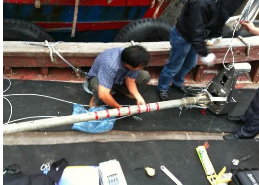
Hình 3.8. Lắp đặt đầu cần phát biển máy đa tia R2 sonic
